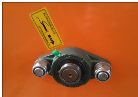
Bild 24: Stehlager in Fahrtrichtung links
