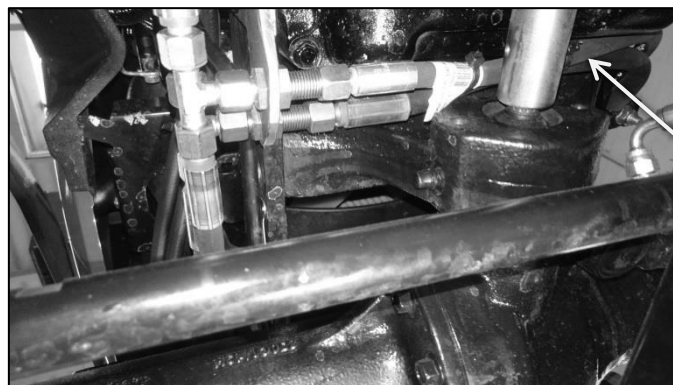
Bild 12: Verlegen der Hydraulikleitungen am Motor
